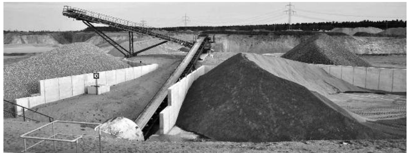
Schüttgutumschlagplatz mit Gleisanschluss, Kieswerk Consrade
