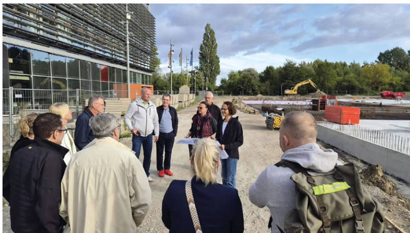
Dipl.-Ing. Jeanette Venohr informierte über die Baustelle
