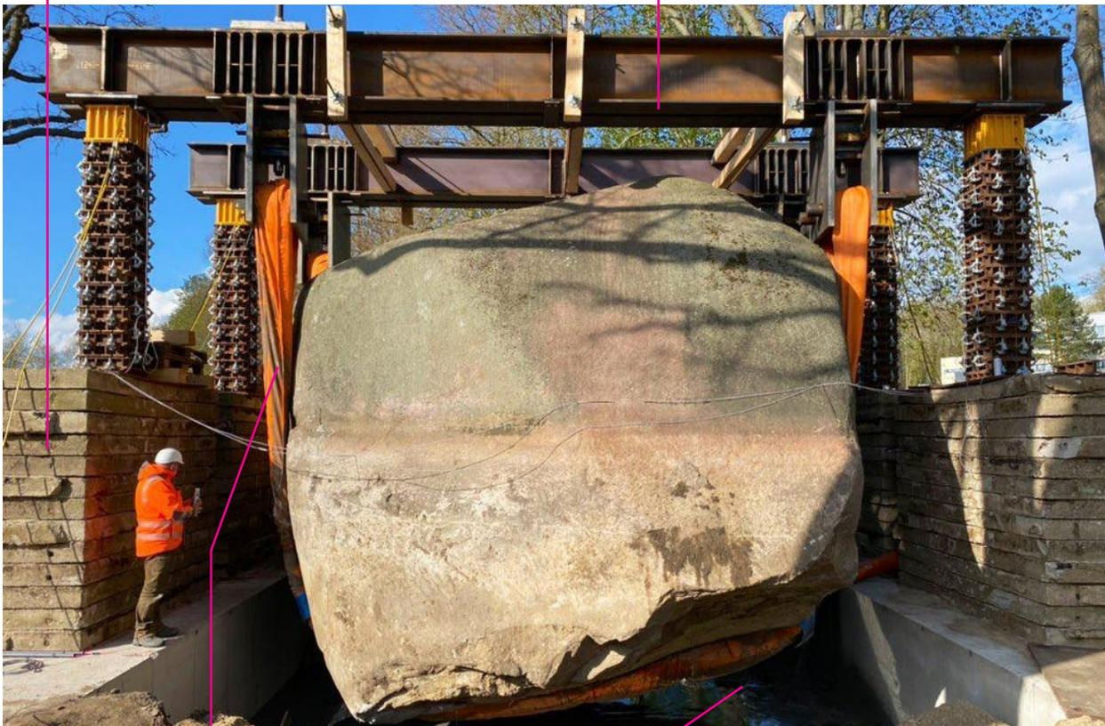
Für die Freilegung mussten Hebegurte unter dem Findling und Streifenfundamente eingebaut werden. Die Hebegurte wurden pro Seite einzeln nacheinander eingebaut.
