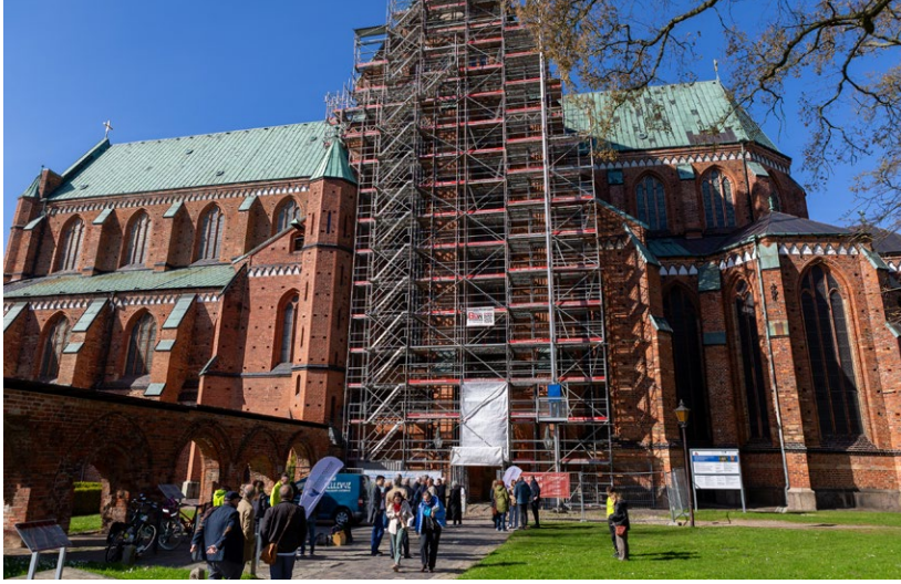
Am Tag der Feierstunde zeigte sich das Münster mit Baugerüst. © Bundesingenieurkammer
