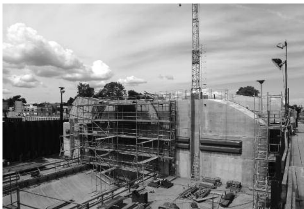
Blick in die für das Drehsegment vorbereitete Schutzanlage.
