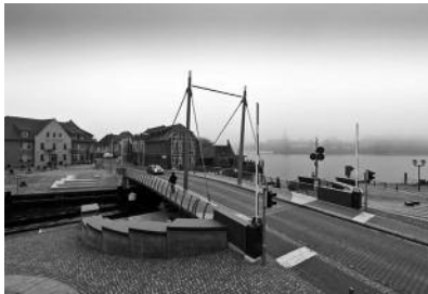
Ersatzneubau Drehbrücke, Inselstadt Malchow Foto: Ingenieurbüro Thiele & Partner
