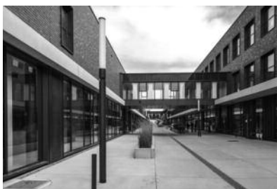
2. Baustufe Gesamtausbau Friedrich-Loeffler-Institut, Insel Riems Foto: Rainer Mader, Henry Dramsch
