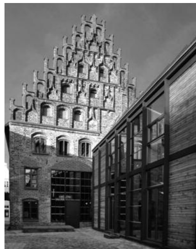
Sanierung und Modernisierung Derz'sches Haus, Güstrow Foto: Schellbauhütte GmbH & Co.KG
