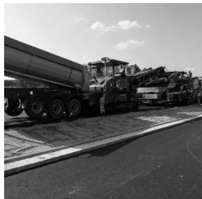
Die Maschinenkolonne beim Aufbringen des Asphaltbelages
