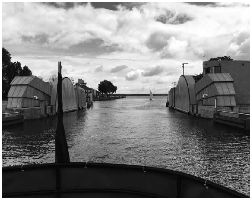
Sturmflutsperrwerk Greifswald-Wieck | Foto: Privat
